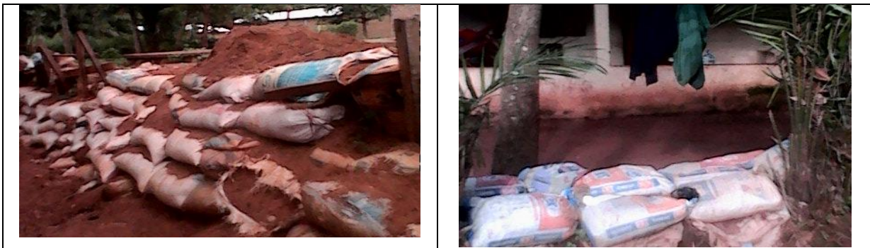
Photo 2: Sacs remplis de terre érigés aux abords des parcelles pour éviter les inondations et les ravinements
